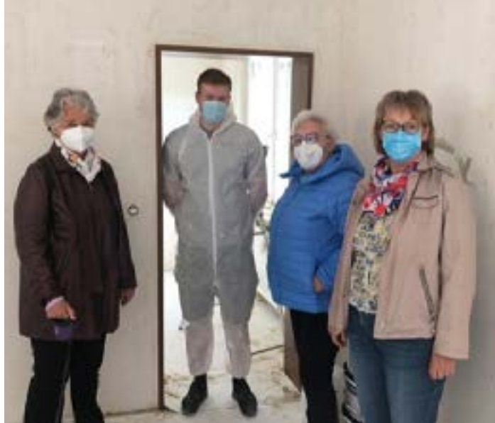
Noch sind die Handwerker im Einsatz. Vorstandsmitglieder der AWO Bergen-Enkheim checken den Stand der Renovierungsarbeiten.
