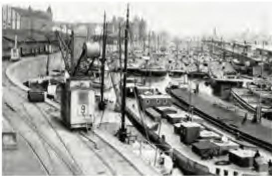
Das **Druckwasserwerk** – heute ein Restaurant – ging auch im Jahr 1886 in Betrieb. Wie die auf dem Bild erkennbaren wasserdruckbetriebenen großen Lastkräne funktionieren, ist in der nächsten Ausgabe zu lesen.
